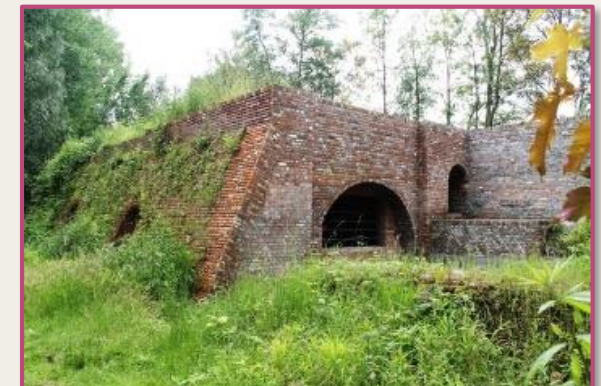
Steenoven Turnhout Four à briques Turnhout
