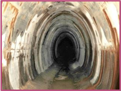
Ondergrondse verlaten metro Métro souterrain abandonné
