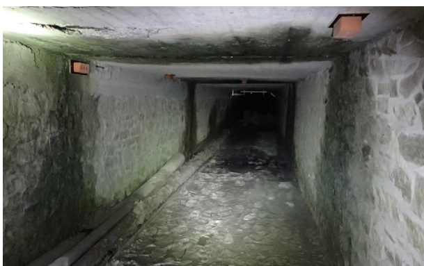
Intérieur d'une galerie technique équipée de micro-gîtes du type « briques creuses » sur panneau marin
