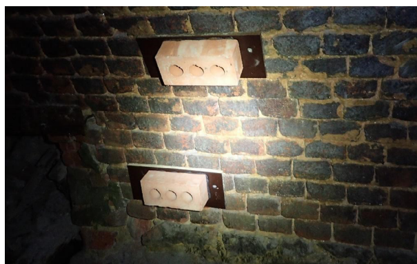
Mise en place de micro-gîtes du type « briques creuses » sur panneau marin
