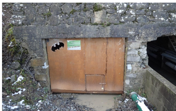
Sécurisation d'une galerie technique
