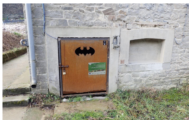
Sécurisation de caves sous des bâtiments
