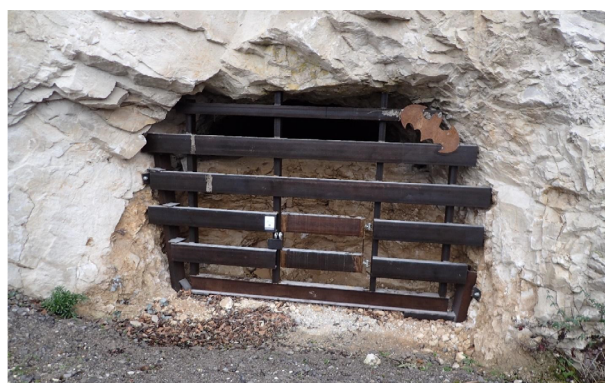
Fermeture d'une ancienne galerie d'exploitation à l'aide de barreaux métalliques
