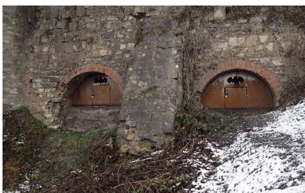
Sécurisation d'anciens fours à chaux
